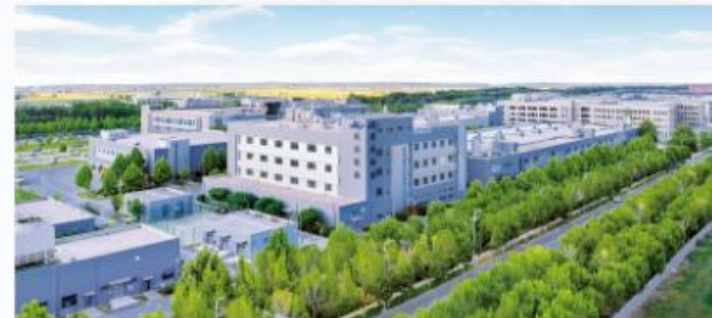
▲ 智能轨道交通主题产业园 (占地面积约2195亩)
